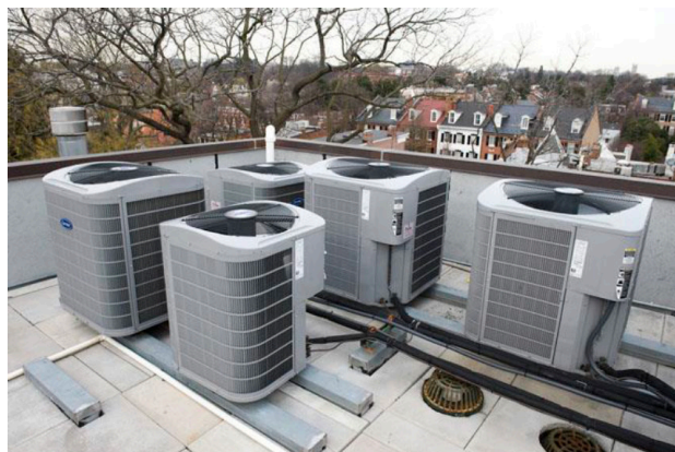
Figur 3. Kondensatorer (luftkølede)
