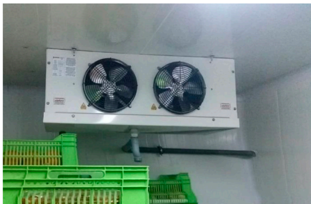
Figur 2. Fordamper (luftkøler)
