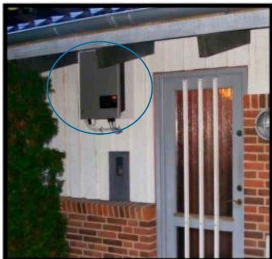
Figur 7. Eksempel på udendørs monteret inverter (Foto: Sikkerhedsstyrelsen)
