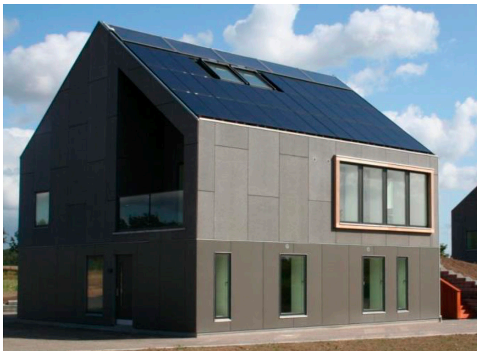
Figur 1. Solceller på tagflade. Foto: Teknologisk Institut
