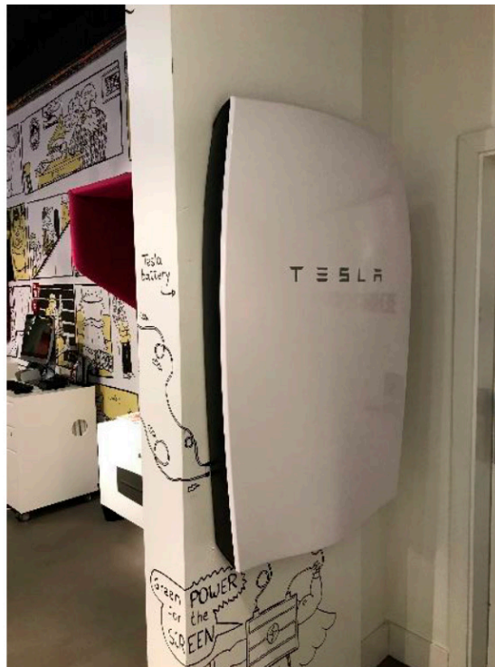
Figur 13 Eksempel på et 5 kWh Batterilager bestående af 15 celler. Til højre en 10 kWh væghængt batteripakke fra Tesla [Teknologisk Institut]
